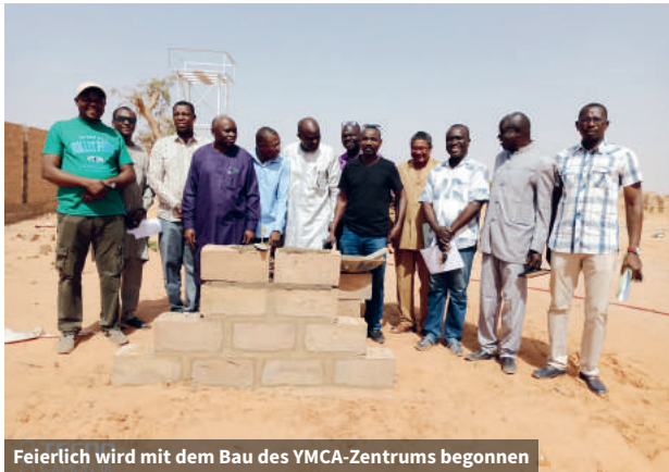
Feierlich wird mit dem Bau des YMCA-Zentrums begonnen
