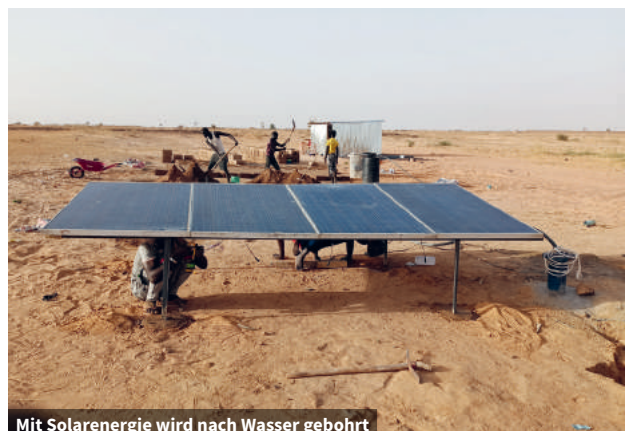
Mit Solarenergie wird nach Wasser gebohrt
