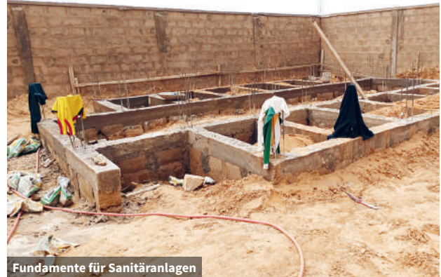
Fundamente für Sanitäranlagen
